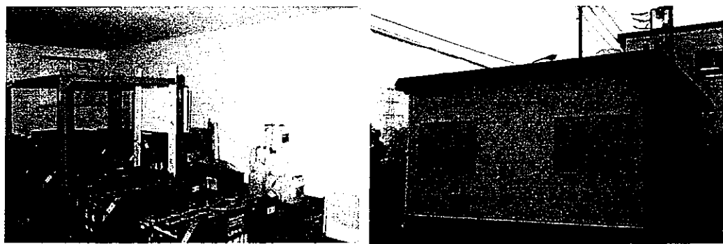
ベンチレーターを設置したバッテリー格納庫(坂戸流通センター)をモデルに
