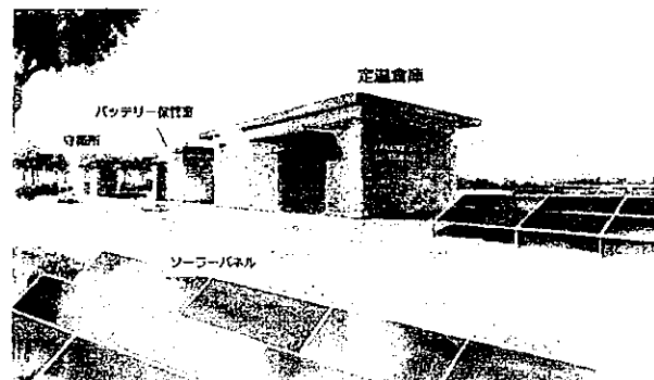
太陽光発電・蓄電方式の定温倉庫のイメージ(農村バージョン)
